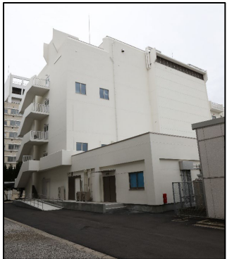
生命科学動物実験ユニット(動物実験施設)
