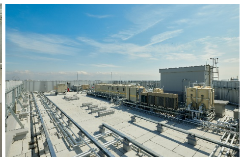
屋上スペース
